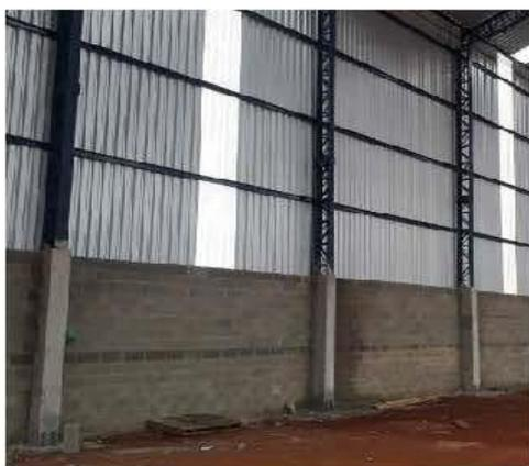
Figura 2 - Fechamento em estrutura metálica.
